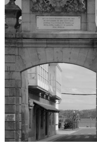
E Porte du Parc de l'arsenal
