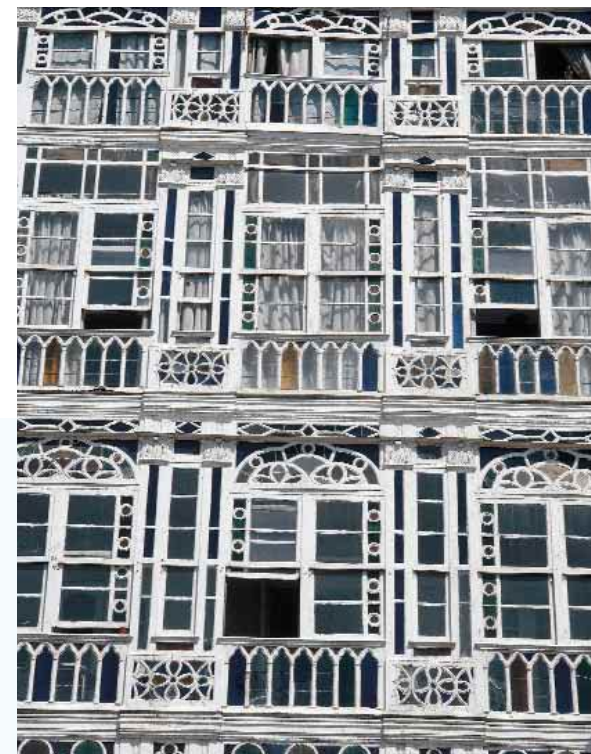
Galerias da Avda. de la Marina (A Coruña)
