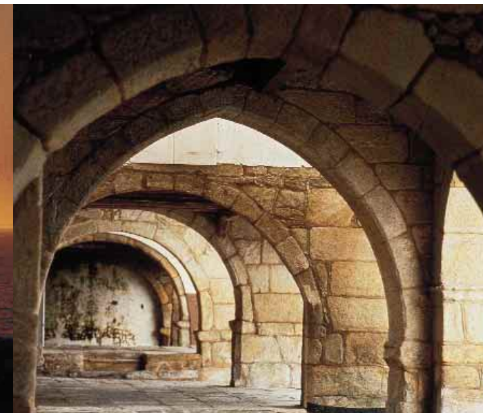
Muros (A Coruña)
