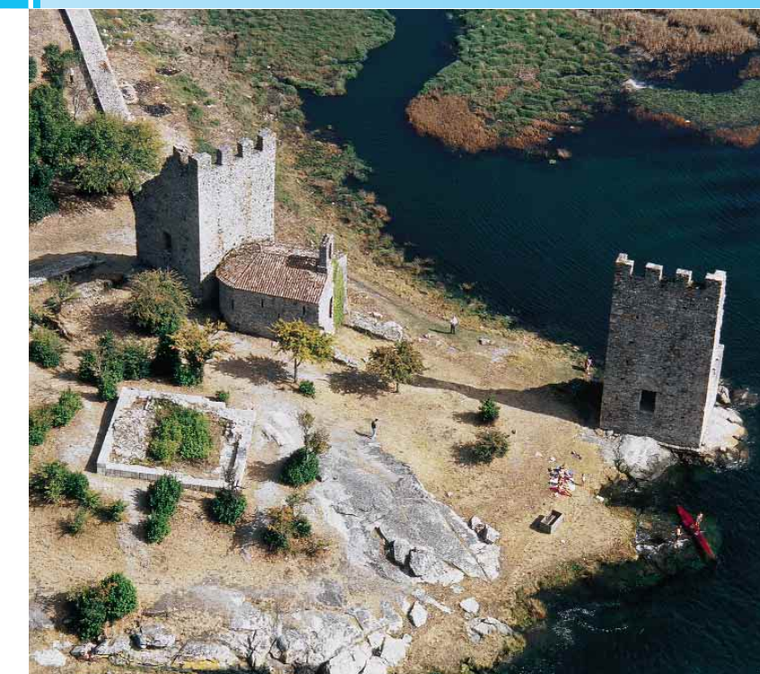
Torres de Oeste, Catoira (Pontevedra)
