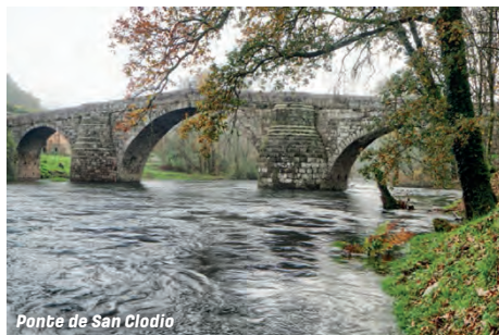
Ponte de San Clodio
