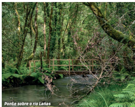
Ponte sobre o río Lañas
