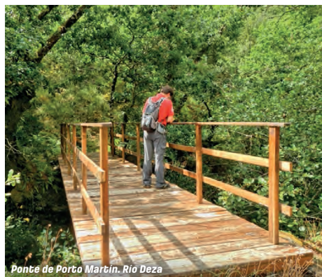
Ponte de Porto Martin. Río Deza
